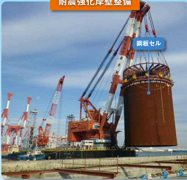
耐震強化岸壁整備
